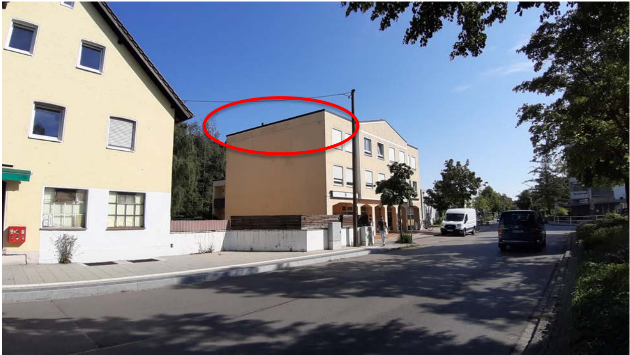
Abbildung 12: Flachdachabschluss des an das Vorhabengebiet unmittelbar östlich angrenzenden Gebäudes (Quelle: DRAGOMIR STADTPLANUNG GmbH, Stand 17.08.2023)
