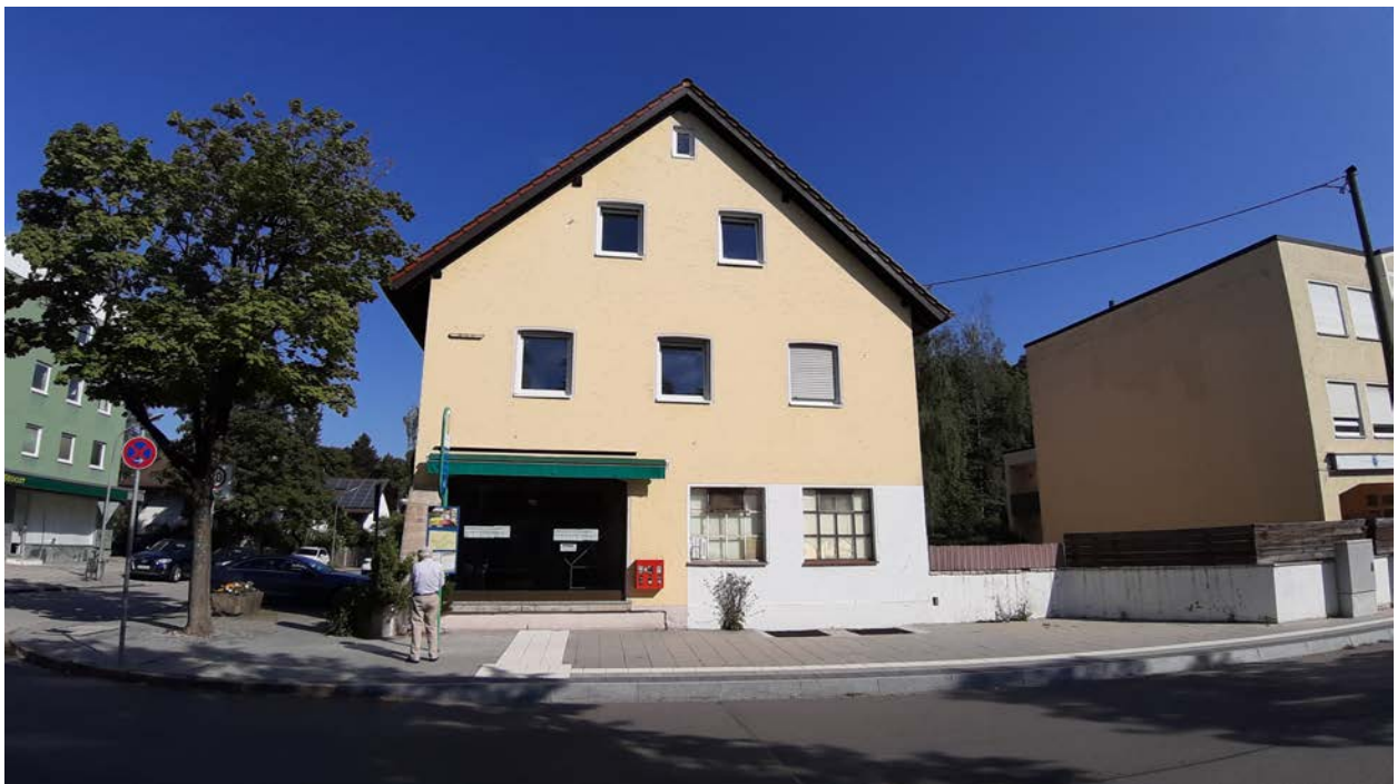
Abbildung 15: Südliche Gebäudefassade des Bestandsgebäudes im Vorhabengebiet
