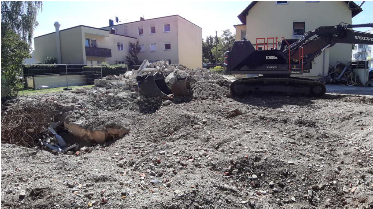
Abbildung 5: Nördlicher Teil des Vorhabengebietes in Blickrichtung Südosten mit Schuttflächen von den bereits erfolgten Gebäudeabrissen, links im Hintergrund ist das unmittelbar angrenzende Nachbargebäude zu erkennen (Quelle: DRAGOMIR STADTPLANUNG GmbH, Stand 17.08.2023)
