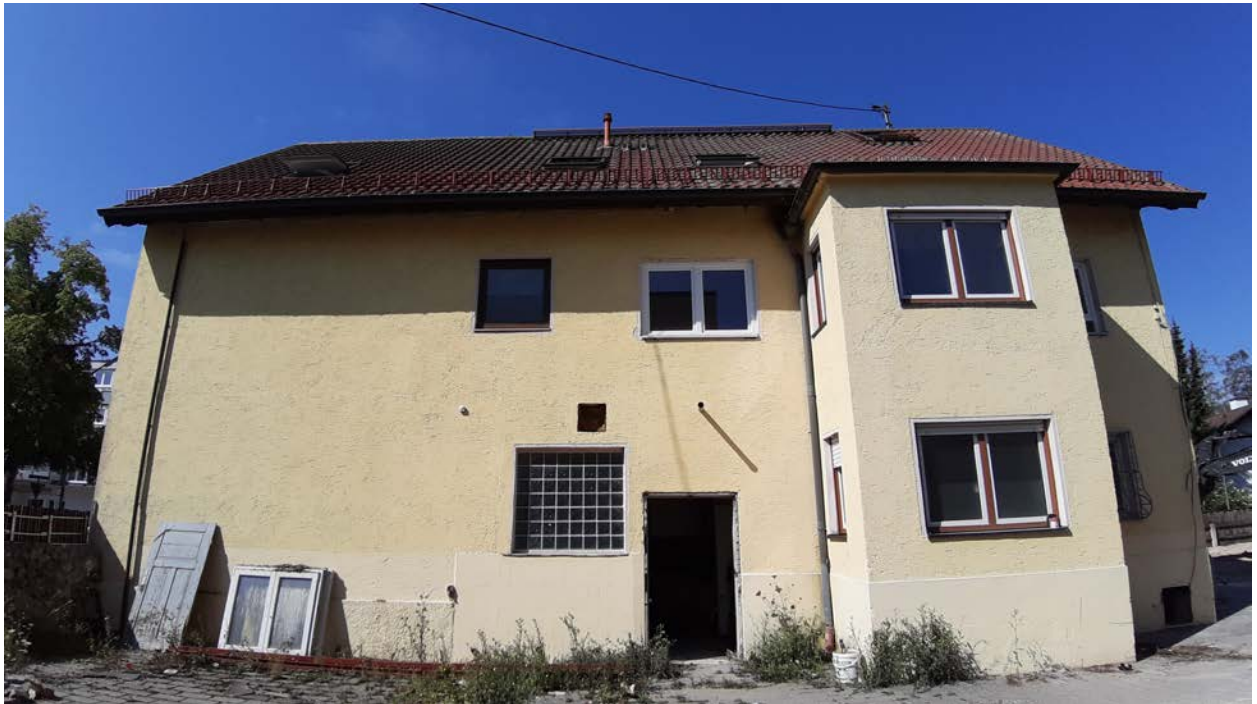
Abbildung 16: Östliche Gebäudefassade des Bestandsgebäudes im Vorhabengebiet
