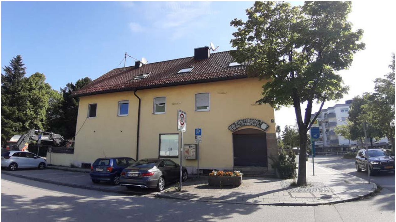
Abbildung 14: Westliche Gebäudefassade des Bestandsgebäudes im Vorhabengebiet
