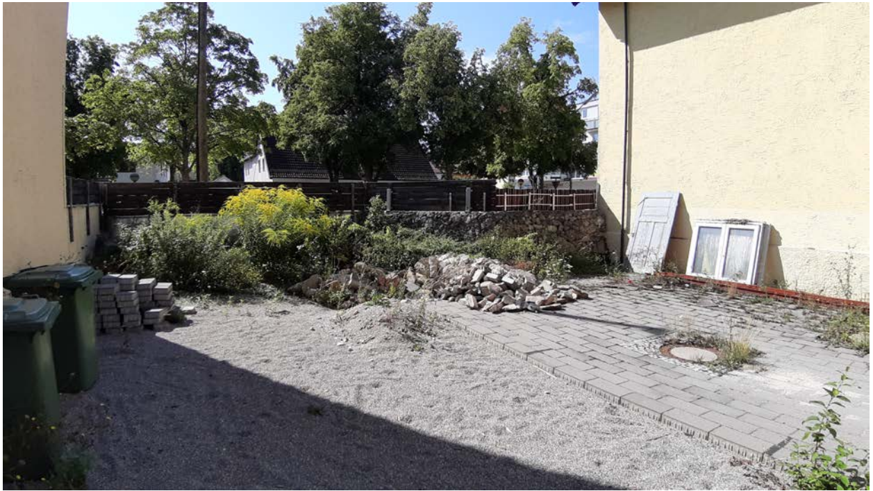
Abbildung 18: Bereich östlich des Bestandsgebäudes im Südosten des Vorhabengebietes
