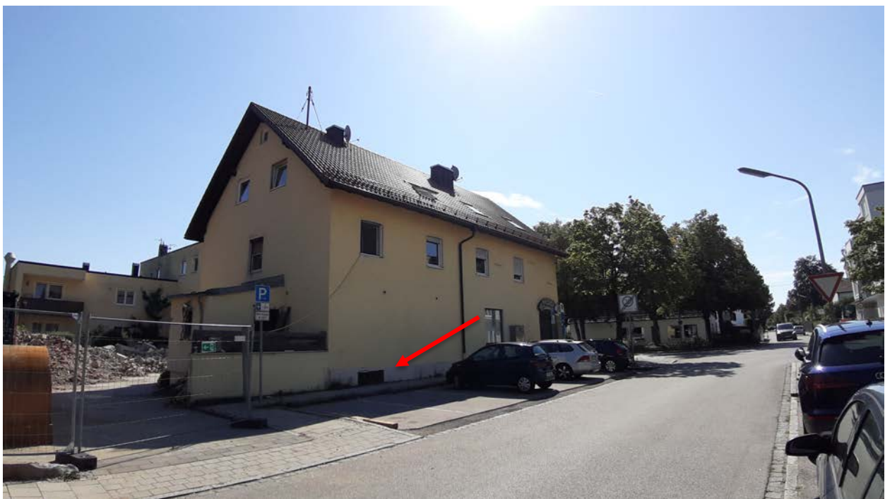
Abbildung 13: Nördliche und westliche Gebäudefassade mit einer von mehreren unverglasten Öffnungen als Einflugmöglichkeit in den Keller (Quelle: DRAGOMIR STADTPLANUNG GmbH, Stand 17.08.2023)
